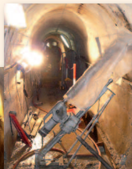
Iniezioni di microcementi MasterRoc MP 800 nei giunti della diga di Place Moulin (Valle d'Aosta)
