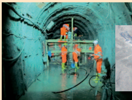
Iniezioni di nanosilice colloidale MasterRoc MP 325 per il consolidamento e l'impermeabilizzazione di sabbia sciolta rifluita in una galleria idroelettrica per la canalizzazione delle acque verso la diga di Olivo (Enna)
