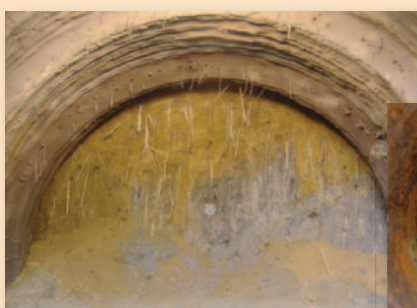
Preconsolidamento e presostegno del cavo in terreni limosi-sabbiosi con resina poliuretanica MasterRoc MP 355 MR0 (Galleria Novilara A14- Tratto tra Cattolica e Fano- Lotto 2)
