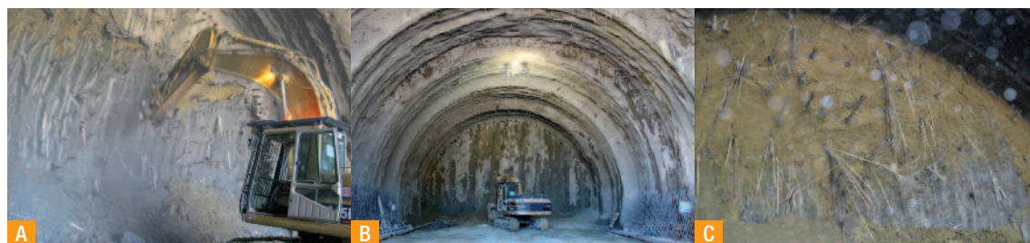
A) Fase di scavo del fronte dopo consolidamento con barre VTR
