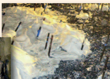
Chiusura di un'imponente venuta d'acqua (400 l/s) con resina poliuretanica bicomponente MasterRoc MP 355 (Circumetnea- Catania)
