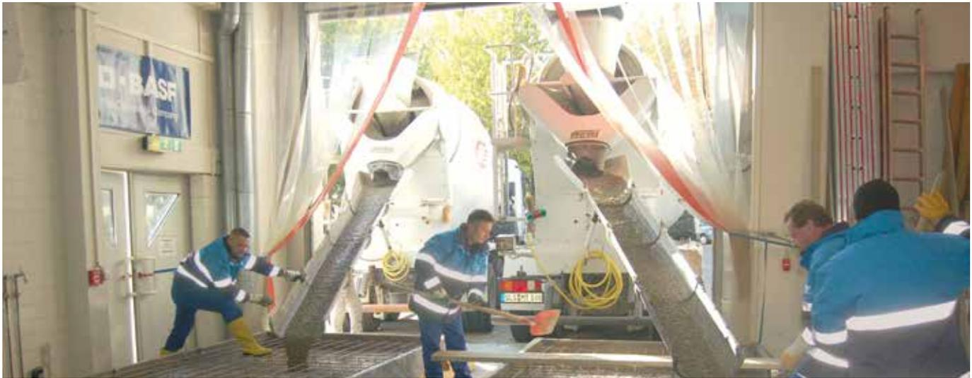
Un solo operatore riesce a mettere in opera il calcestruzzo Smart Dynamic più velocemente di 3 operatori impegnati nel getto di un tradizionale calcestruzzo vibrato
