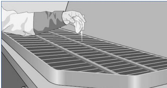
1 Beutel (200 g) in den mit 25 Liter Wasser gefüllten Trichter der Betonpumpe geben. Für längere Pumpleitungen oder grössere Betonpumpen die Menge entsprechend erhöhen.
