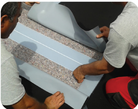
Yalıtım bandı uygulaması
