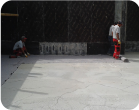
Yüzey hazırlığı ve keçe serilmesi
