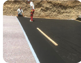
Membranın yerleştirilmesi ve birleştirilmesi
