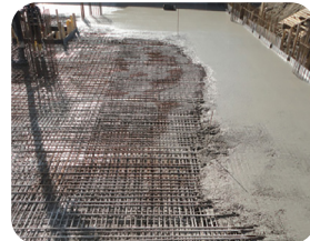
Beton dökümü
