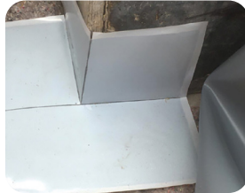
Köşe detaylarının yerleştirilmesi
