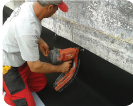
Yalıtım membranının sabitlenmesi
