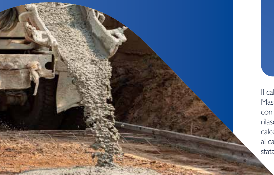
Calcestruzzo con basso contenuto di fini (-6l kg fini/m 3 ) con MasterMatrix LF
