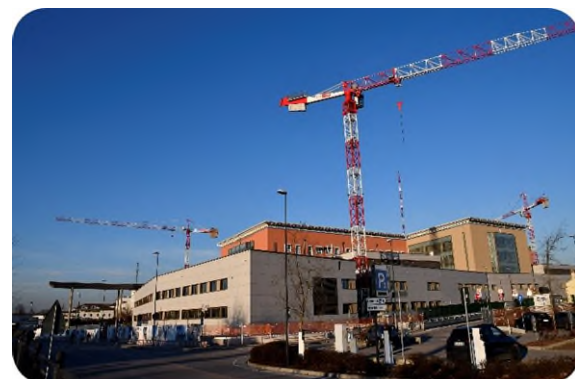
Fase dei lavori a Gennaio 2022, edificio A 29
