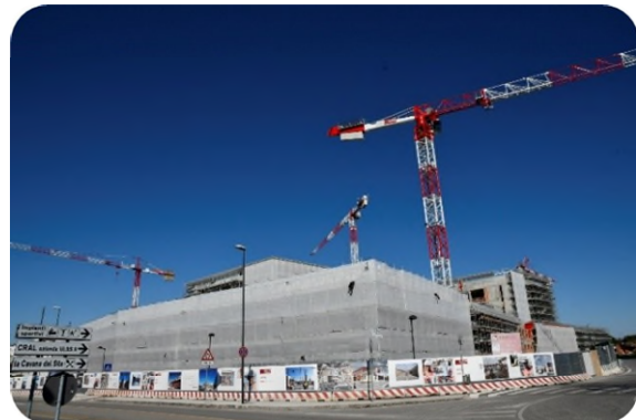
Fase dei lavori a Febbraio 2021, edificio A 29
