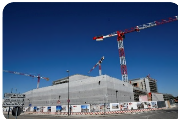
Fase dei lavori a Febbraio 2021, edificio A 29
