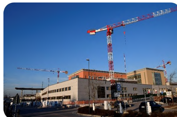
Fase dei lavori a Gennaio 2022, edificio A 29
