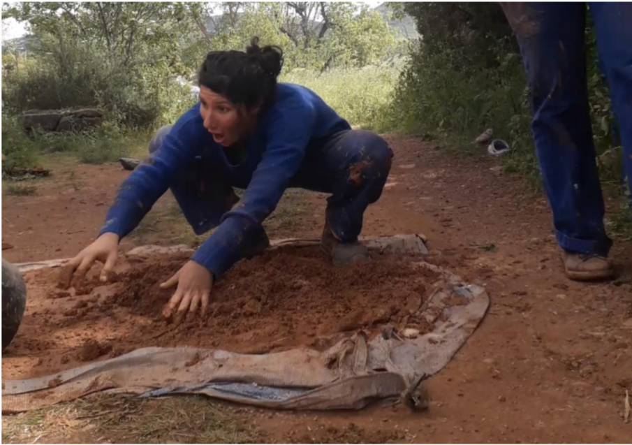
Réalisation d'un mélange de bauge (terre et fibres) dansé, Octon, 2024
