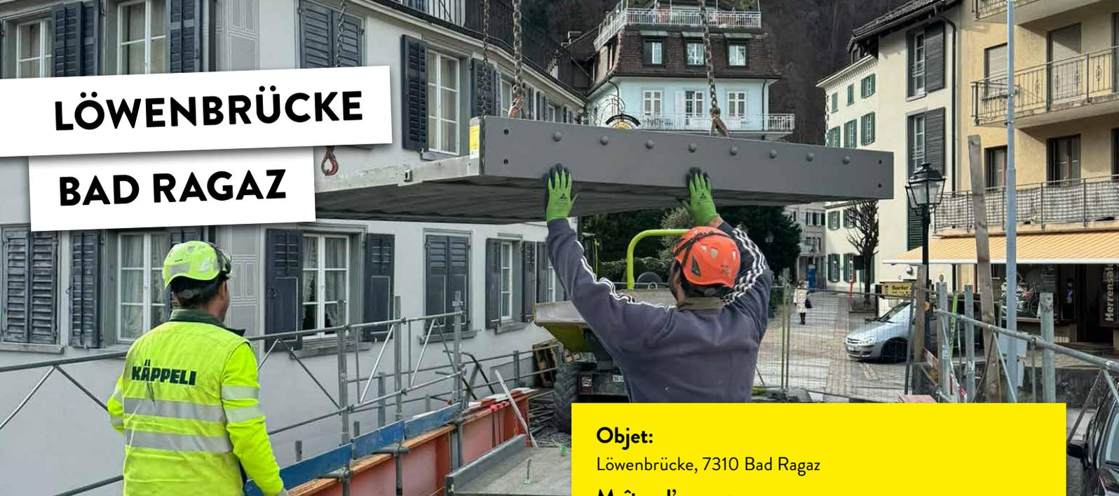
À cause du mauvais état de sa structure et dans l'optique de garantir la sécurité des usagers et usagères, le Löwenbrücke, à Bad Ragaz, avait besoin d'une rénovation. MÜLLER STEINAG ELEMENT AG a ainsi fabriqué un nouveau pont en béton fibré à ultra-hautes performances (BFUP) et l'a livré à Bad Ragaz.
