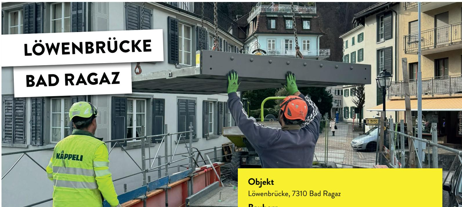
Wegen des baulich schlechten Zustandes in Verbindung mit der Gewährleistung der Sicherheit für Benutzerinnen und Benutzer musste die Löwenbrücke in Bad Ragaz erneuert werden. Für die Sanierung durfte die MÜLLER-STEINAG ELEMENT AG eine neue Brücke aus Ultra-Hochleistungs-Faserverbund-Baustoff (UHFB) herstellen und nach Bad Ragaz liefern.
