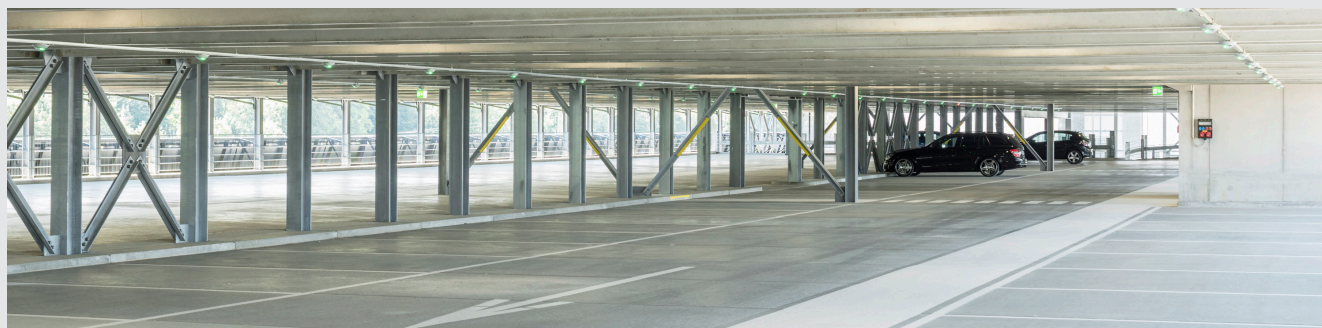
Blick in ein Zwischengeschoss mit den vorgespannten Rippendecken, ohne störende Zwischenstützen, da sich diese ausschliesslich auf der Mittel- und Fassadenachse befinden. (Photo Beat Ernst, © Roche Ltd.)
