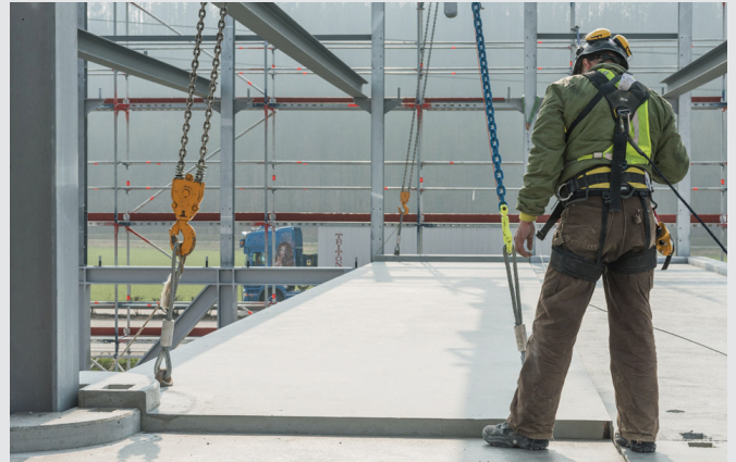
Am Bestimmungsort wird das Element in die Horizontale gedreht und passgenau auf dem Tragwerk abgesetzt. (Photo Beat Ernst, © Roche Ltd.)
