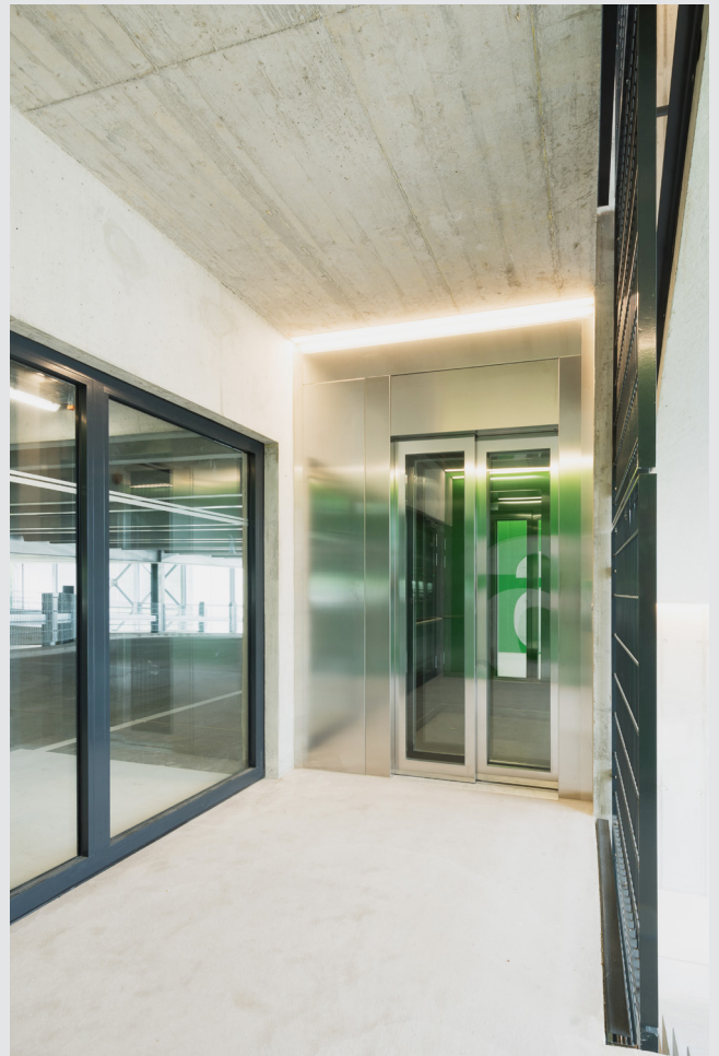
Innenansicht Treppenhaus und Lift.
