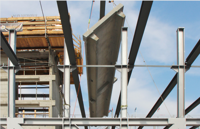
Absenken der Elemente/Fahrbahnplatten zwischen den Stahlstützen in den Obergeschossen, infolge enger Platzverhältnisse bei gleichzeitiger Schiefstellung des Elementes.
