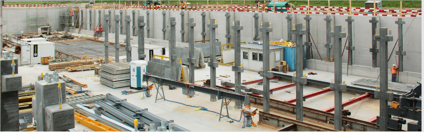
Montagebeginn mit Blick in die Baugrube und den 2-geschossigen Stützen, wobei alle Elemente in den Untergeschossen brandbeständig ausgelegt werden mussten.
