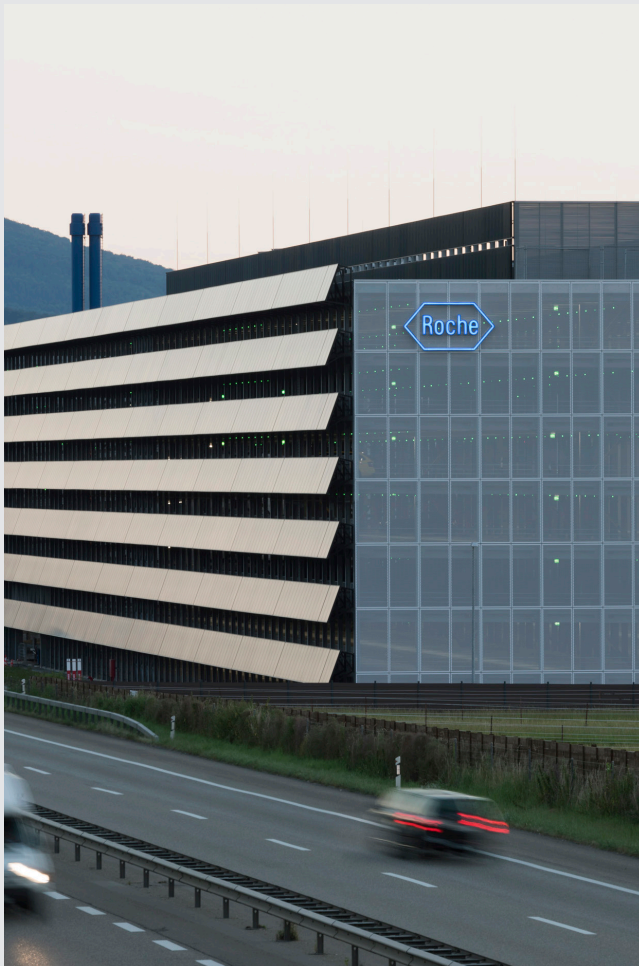
Aussenansicht mit Photovoltaikanlage, Lochblechfassade und Einkleidung Rückkühlereinheiten auf dem Dachgeschoss. (Photo Beat Ernst, © Roche Ltd.)
