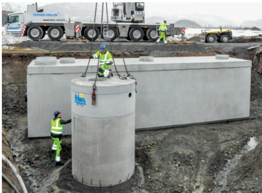
Zusätzlich zum Betonkubus, welcher Schlammfang und Mineralölabscheider in einem Element kombiniert, kam ein separater Ölrückhaltebehälter (ORB), sowie ein Schacht für Probeentnahmen vor dem Einleiten des Wassers in ein Versickerungsbecken hinzu.
