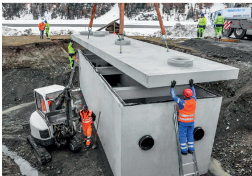
Die massgeschneiderte Abdeckplatte wird auf der friwa®-Box, welche eine Abmessung von 11 x 3 x 3 Meter aufweist, millimetergenau positioniert.
