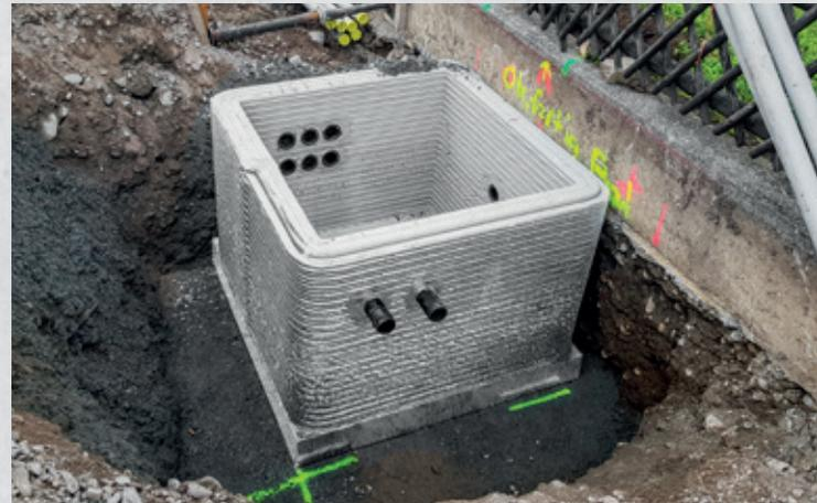
Produziert wurde «just in time». Nach Druck und Aushärtung wurde der Schacht keine 24 Stunden später ausgeliefert und direkt in die Baugrube versetzt. Wie bei Betonvorfabrikaten generell sind die Vorteile des 3D-Beton-Drucks noch mehr Zeitersparnis, Wirtschaftlichkeit und die Möglichkeit, auf individuelle Kundenbedürfnisse eingehen zu können. Das alles mit lokalen, heimischen Rohstoffen. Die Umwelt dankt's, wird die sogenannte graue Energie doch gering gehalten.
