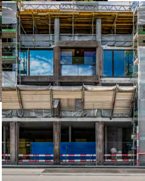
Diese 1:1-Musterfassade wurde extra von der MÜLLER-STEINAG ELEMENT AG erstellt, während der Rohbau auf der Baustelle weiter seinen Lauf nahm. Bauherrschaft und Architekten erhielten so die Gewähr, dass das Fassadenbild zuletzt auch wirklich den Vorstellungen entsprach.
