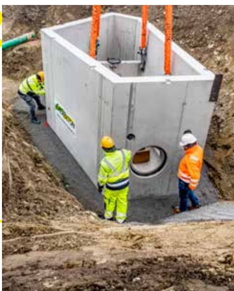
Die Elemente werden mit dem Pneukran punktgenau versetzt.
