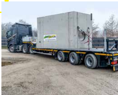
Just-in-Time treffen die vorgefertigten Elemente auf der Baustelle ein.
