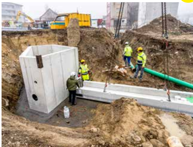
Der Verbindungskanal wird an den Hauptschacht angeschlossen.
