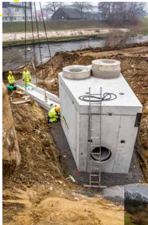
Innert fünf Stunden wurden die Elemente fachgerecht montiert.
