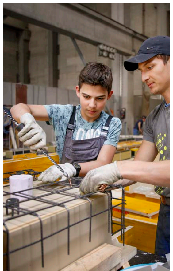
Simon Wermelinger führt im Werk Rickenbach Armierungsarbeiten an seinem Brunnen aus.
