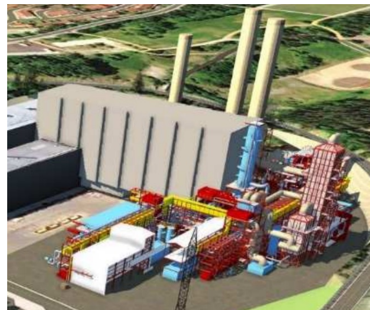
Source: Fortum Oslo Varme AS – Vue 3D du projet de capture du CO 2 à l'usine de valorisation énergétique des déchets Hafslund Celsio à Oslo, en Norvège, avec des colonnes verticales à contre-courant traditionnelles
