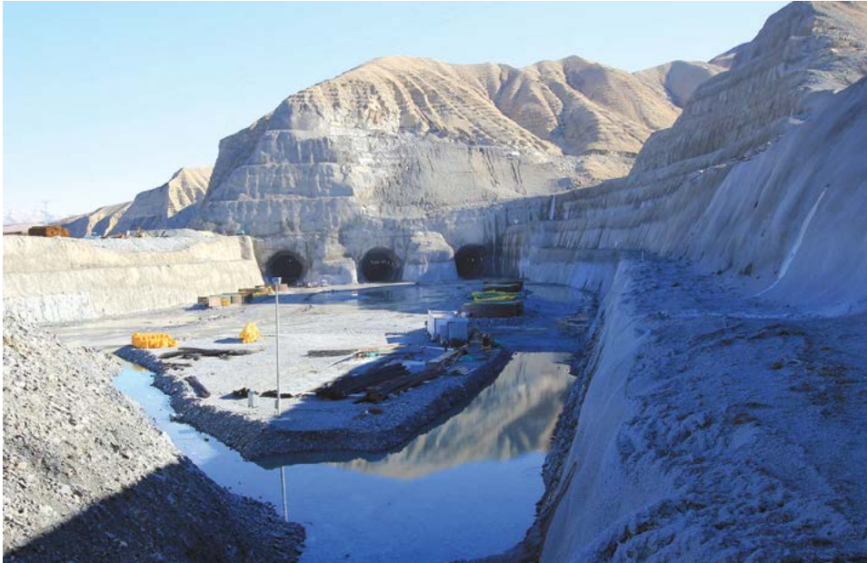
Baraj Derivasyon Tünelleri İnşaatından Bir Görüntü
