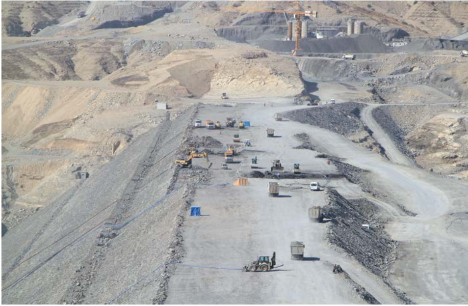
Baraj İnşaatından Bir Görüntü
