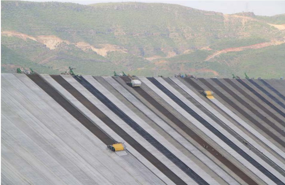
Ön Yüzü Beton Kaplama Çalışmalarından Bir Görüntü
