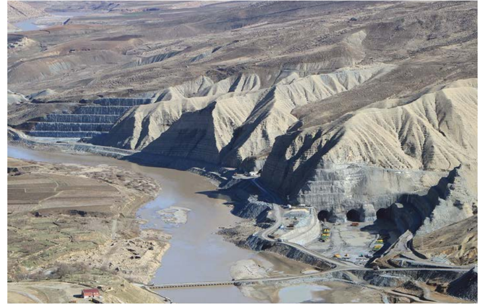
Derivasyon Tüneli İnşaatlarından Bir Görüntü
