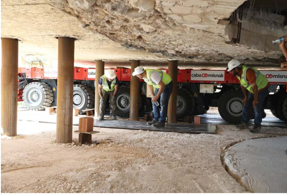
Zeynel Bey Türbesinin Kaldırma Temeli ve Hidroliklerin Yerleştirilmesi
