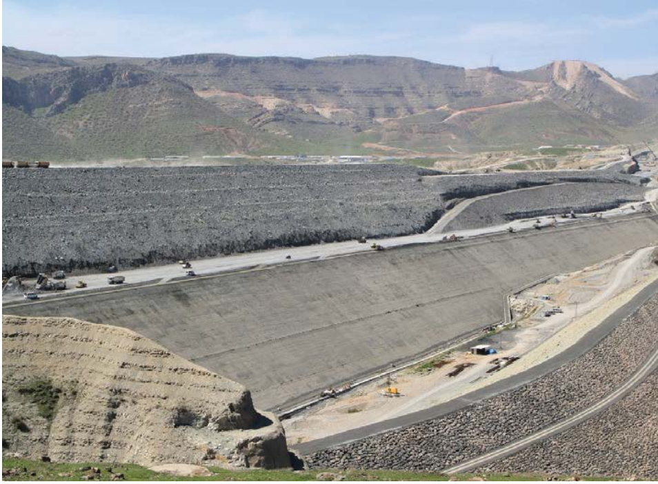
Baraj İnşaatından Bir Görüntü
