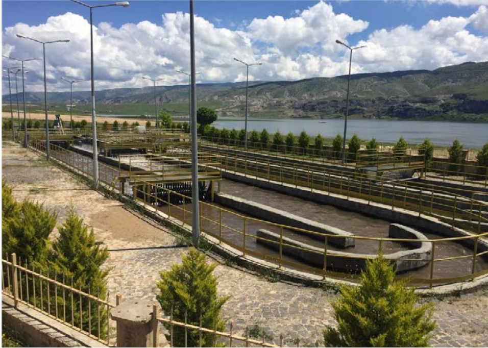
Hasankeyf Atıksu Arıtma Tesisi
