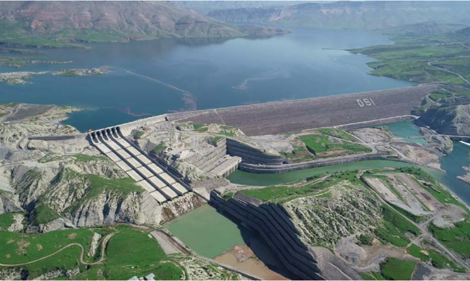
Ilısu Barajı Genel Görünüm
