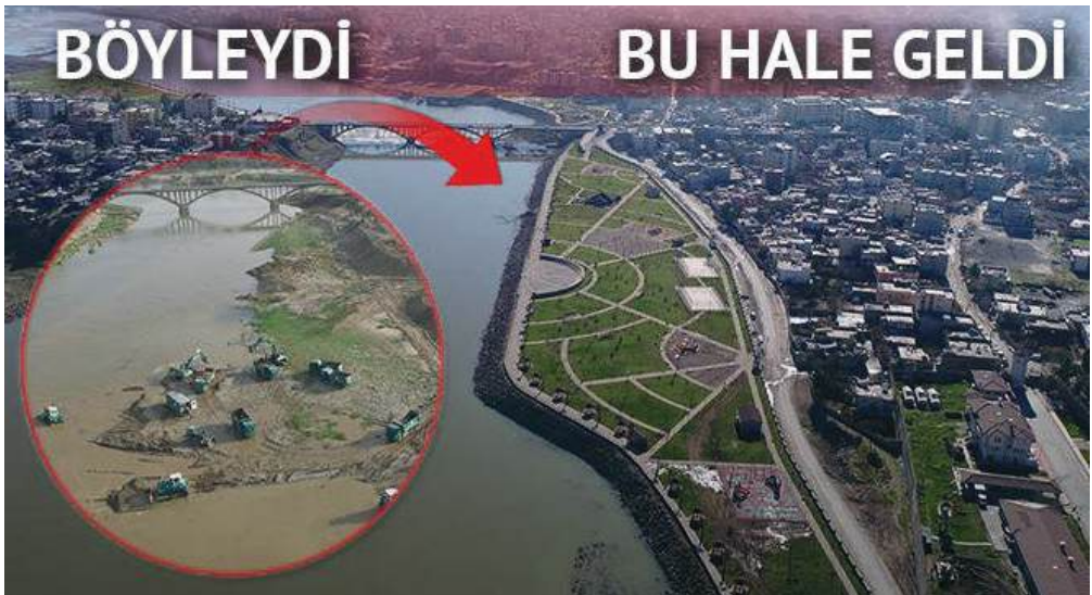
Cizre İlçesi Dicle Nehri Islahı
