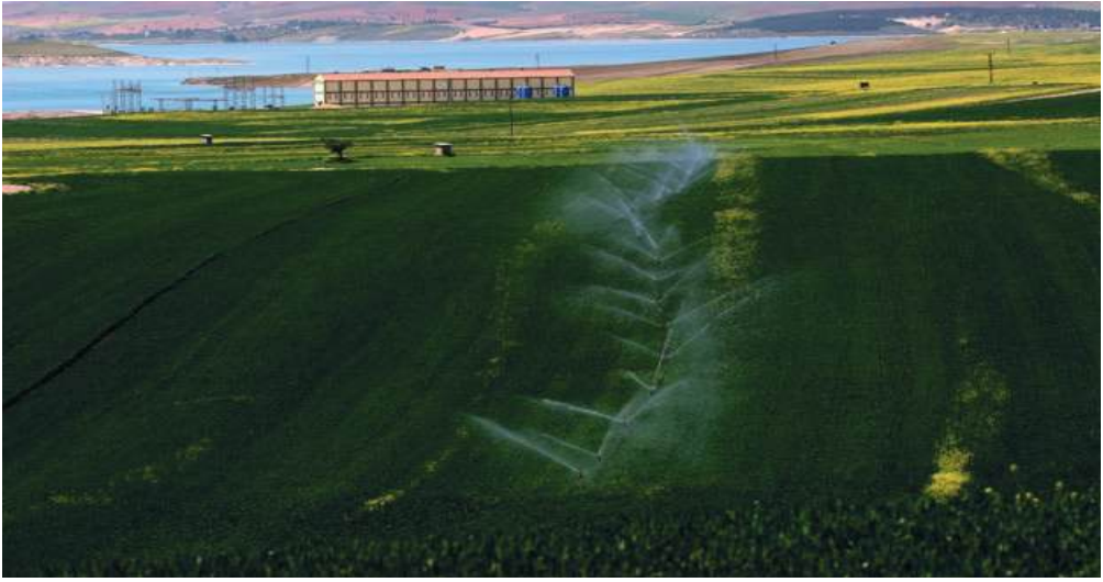
Şanlıurfa Bozova 1. Kısım Sulaması
