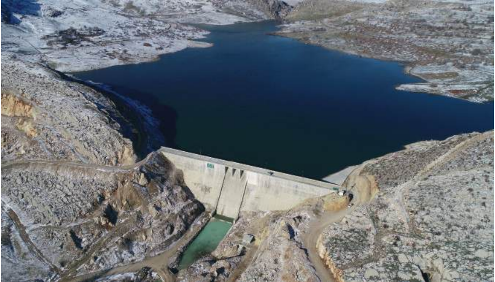
Diyarbakır Ergani Barajı
