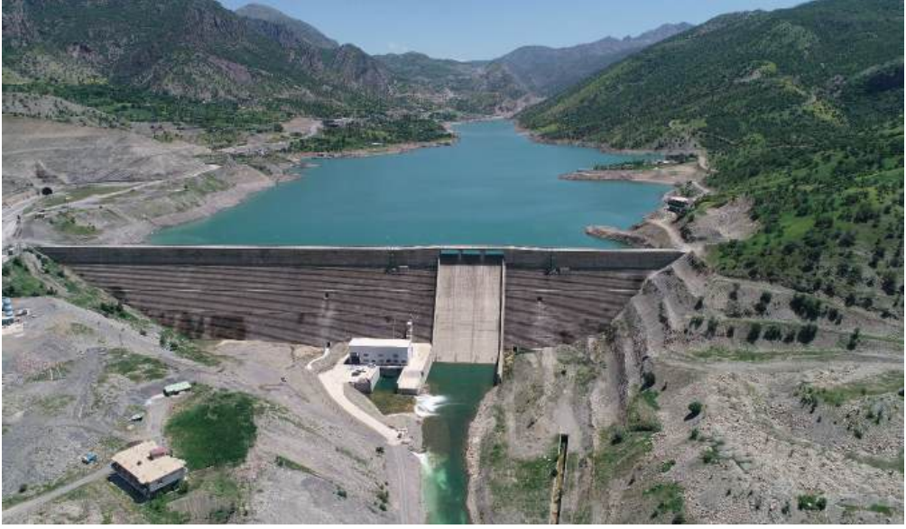
Şırnak Uludere Barajı
