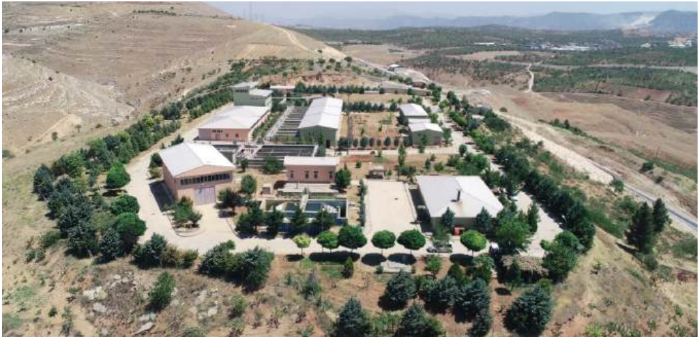
Siirt İçmesuyu Arıtma Tesis
