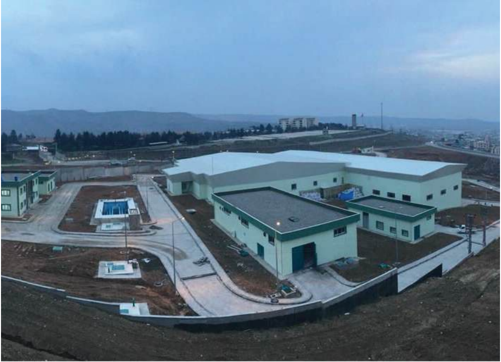
Şırnak Cizre İçmesuyu Arıtma Tesis
