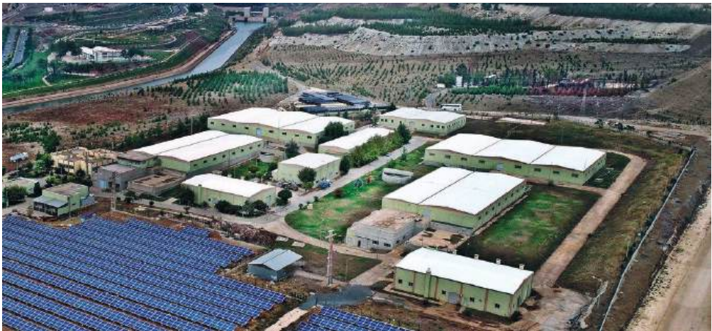
Şanlıurfa İçmesuyu Arıtma Tesisi
