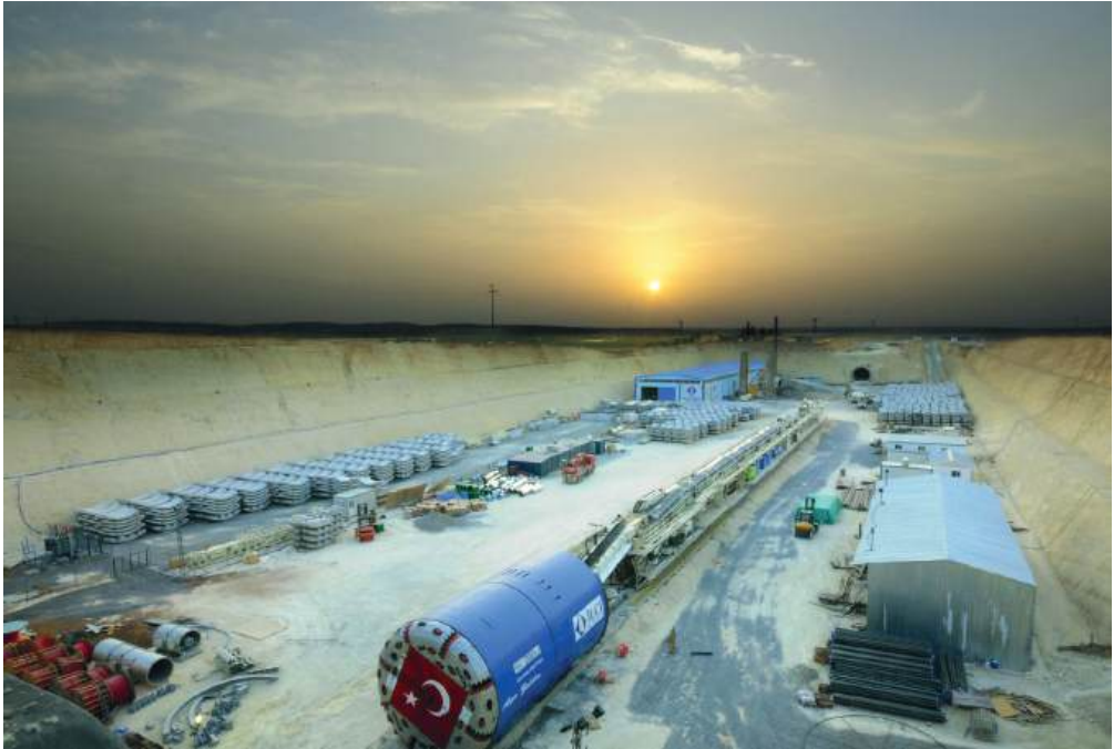
Suruç Tüneli TBM Makinası
