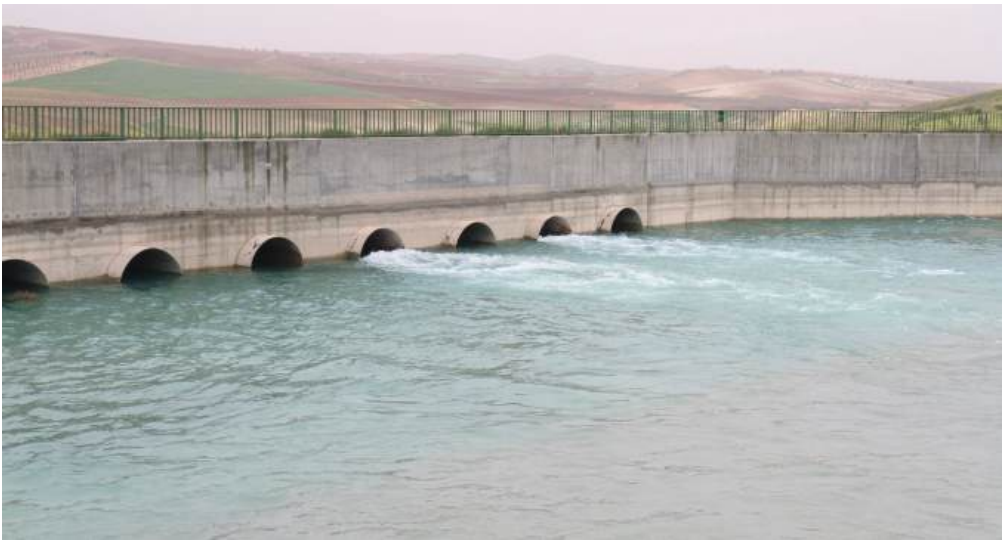
Suruç Ovası Su İletim Kanalı
