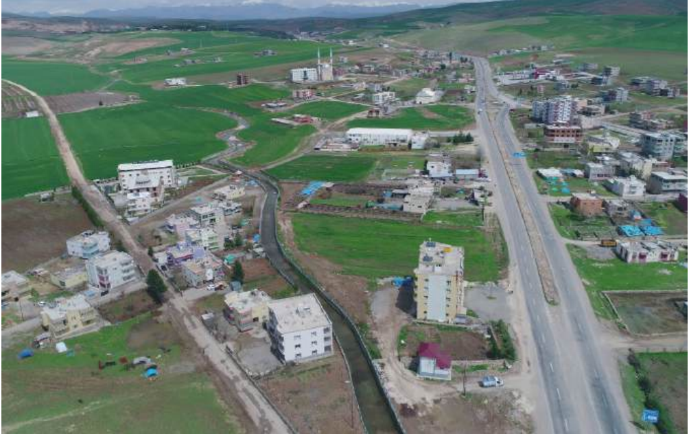
Siirt Kurtalan Taşkın Koruma Tesisi
