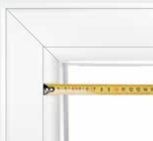
Empfohlener Messpunkt: Glasleistenfuge ggf. auf Beschläge achten
