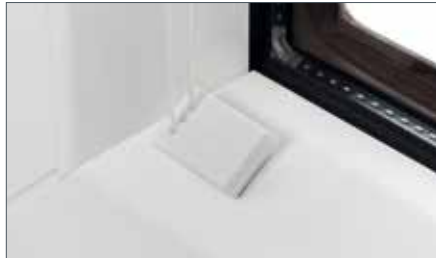
konisch schräge Glasleiste (Tiefe 15 mm) mit Spannschuh
