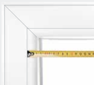
Empfohlener Messpunkt: Glasleistenfuge ggf. auf Beschläge achten
