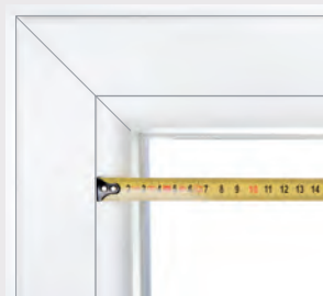
Empfohlener Messpunkt: Glasleistenfuge ggf. auf Beschläge achten
