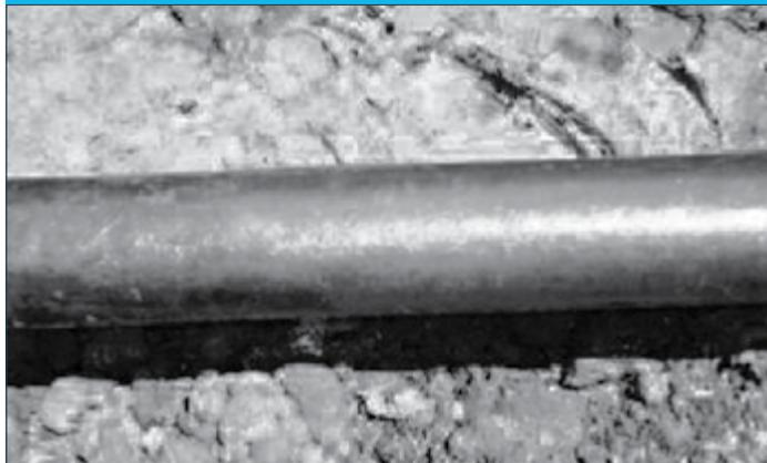
Tuyau en fonte grise de 4 po (100 mm) recouvert de polyéthylène lâche de 8 mil.
