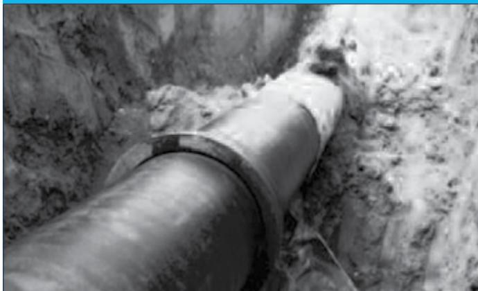
Tuyau en fonte ductile de 12 po (300 mm) recouvert de polyéthylène lâche de 8 mil.
