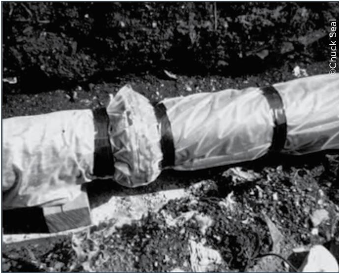
Comme pour tout système de protection contre la corrosion, l'installation appropriée de la gaine de polyéthylène est essentielle. La gaine de polyéthylène doit être installée soigneusement en adoptant l'une des trois méthodes d'installation décrites dans la norme ANSI/AWWA C105/A21.5.
