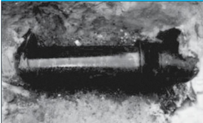
Tuyau en fonte grise de 12 po (300 mm) recouvert de polyéthylène lâche de 8 mil.
