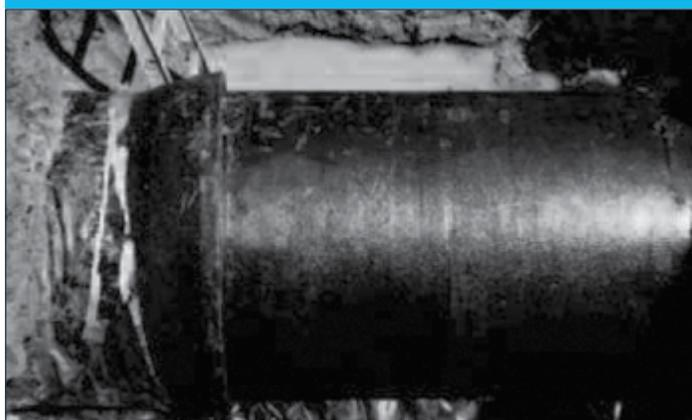
Tuyau en fonte ductile de 30 po (750 mm) recouvert de polyéthylène lâche de 8 mil.
