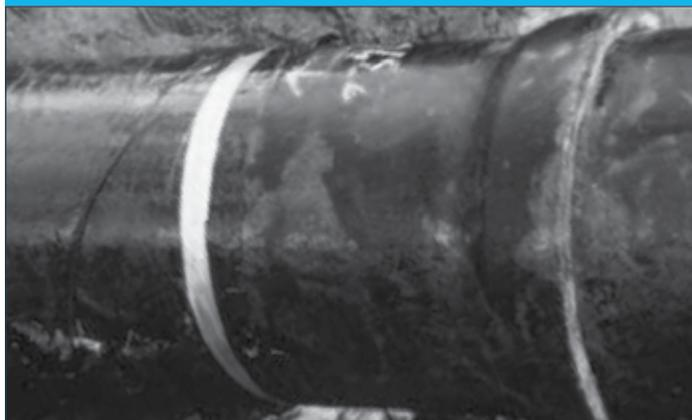
Tuyau en fonte ductile de 24 po (600 mm) recouvert de polyéthylène lâche de 8 mil.
