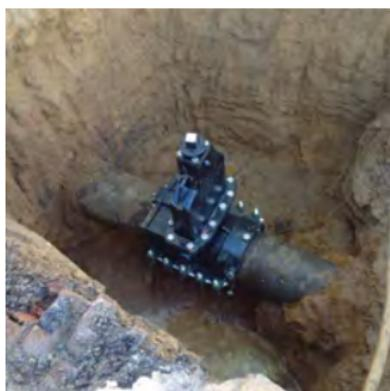
alternativa, se puede utilizar una camisa sólida para instalar una válvula nueva en una cañería existente. Con este método, la válvula se deberá sostener firmemente en la línea utilizando una pieza de tubo para rellenar el espacio dentro de la camisa, de manera que cuando haya presión de
