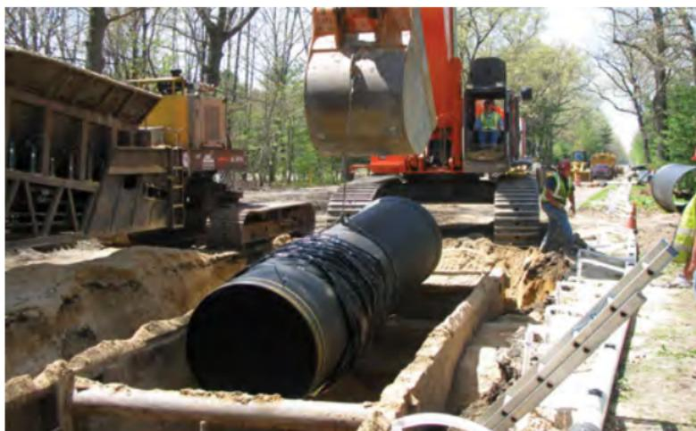
**1.4 Eslingas:** existe una variedad de eslingas disponibles para manejar los tubos. Las eslingas de nailon, con una capacidad de elevación adecuada, son particularmente apropiadas para elevar tubos y accesorios de hierro dúctil.
