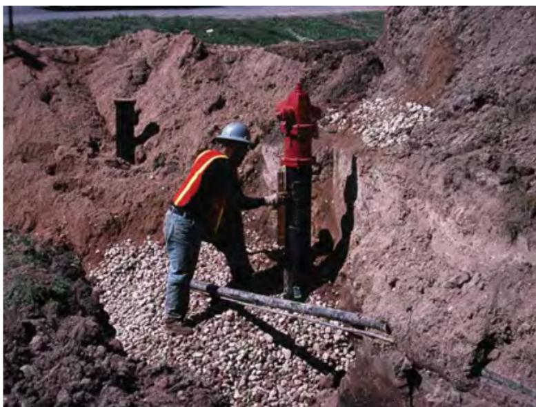
La mayoría de las bocas de incendios tienen una marca de nivel de suelo y deben pedirse para la profundidad adecuada de la cubierta de la tubería de manera que las boquillas de las mangueras y de las autobombas estén a la altura correcta. La línea de conexión a la cañería de suministro no debe tener menos de 6 pulgadas de diámetro. Consulte el manual M-17 de la AWWA para obtener información sobre la instalación adecuada de las bocas de incendios.
