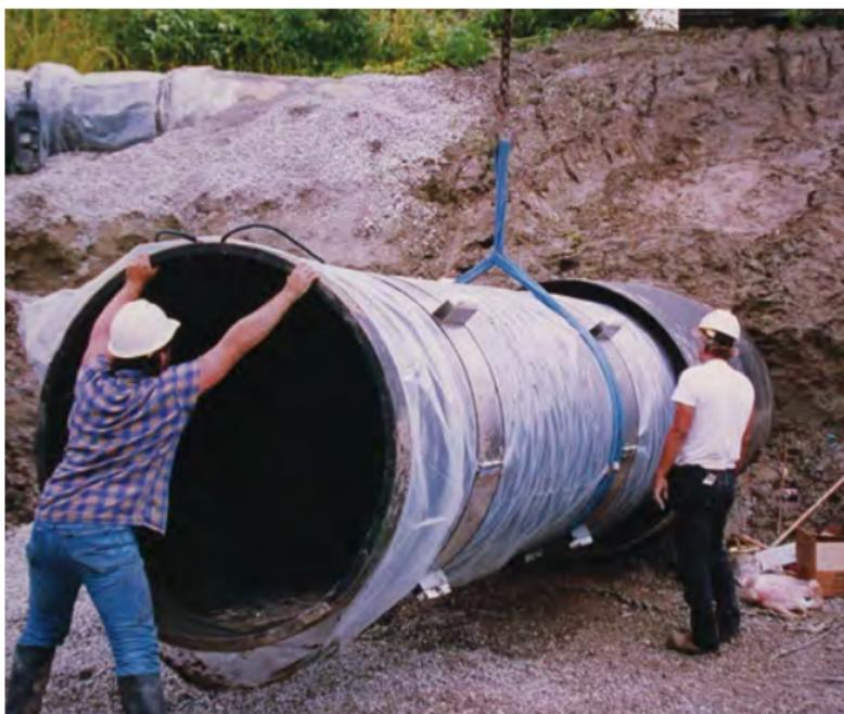
En los casos donde se requiera un revestimiento, el tubo de hierro dúctil se jala o empuja a través del tubo de revestimiento previamente instalado. El tubo de revestimiento debe ser de 6 a 8 pulgadas más grande que el diámetro exterior de las campanas de los tubos de hierro dúctil.
