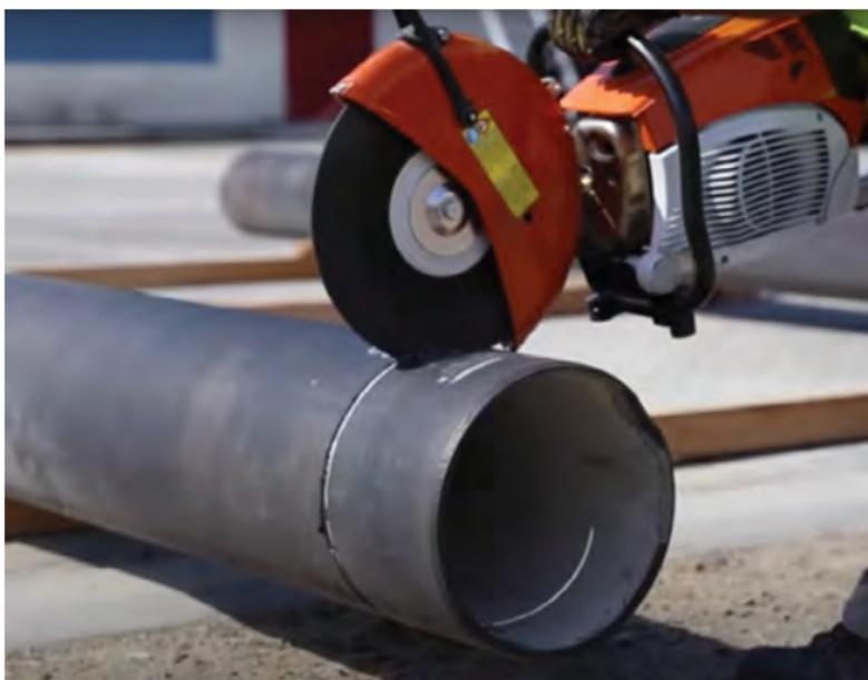
**3.11 Corte de tubos:** el tubo de hierro dúctil se puede cortar utilizando una sierra de corte abrasivo, un cortador giratorio, una sierra tipo guillotina, una sierra de cadena fabricada específicamente para cortar tubos de hierro dúctil, o una sierra circular. El tubo también se puede cortar con un soplete oxiacetilénico si el fabricante del tubo lo recomienda.
