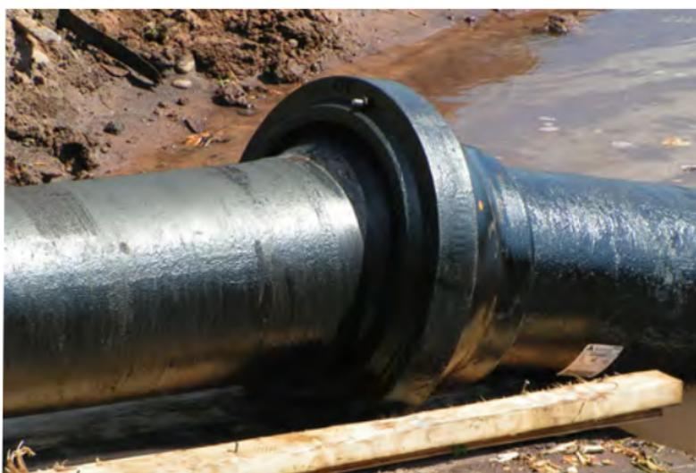
Otro método de instalación consiste en ensamblar la tubería en tierra y arrastrarla a su posición a lo largo del fondo. También se puede hacer flotar la tubería hasta su posición adosándole barriles o flotadores, que serán perforados o liberados de manera controlada cuando la tubería alcance la posición deseada.
