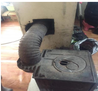
Дүрслэл 4. Яндангийн битүүмжлэл муу, дахин битүүмжилсэн байдал
