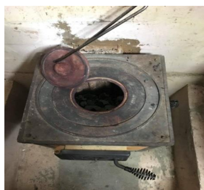
Дүрслэл 4. Яндангийн битүүмжлэл муу, дахин битүүмжилсэн байдал
