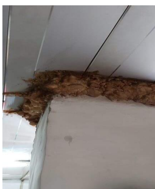
Дүрслэл 4. Яндангийн битүүмжлэл муу, дахин битүүмжилсэн байдал
