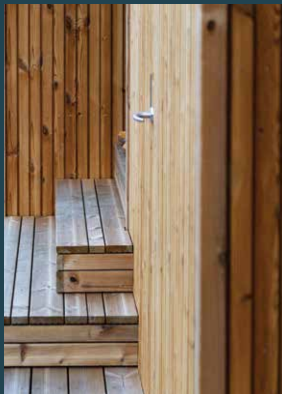
Konstruktionen omkring flugtvej og indsatsvej er brandimprægneret.
