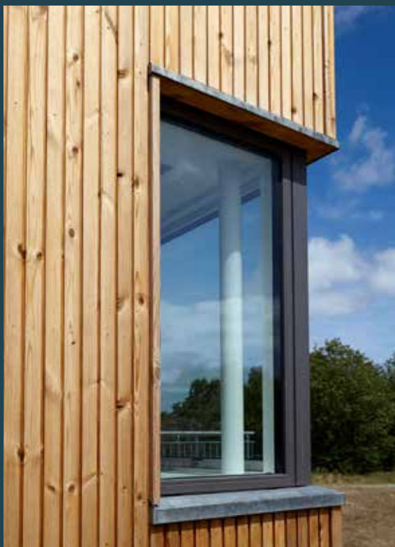
Der er indarbejdet brandstop under alle vinduer.
