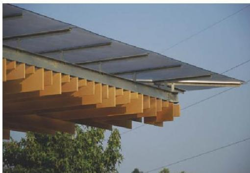
Dettaglio della pensilina: si nota la sottostruttura in acciaio e i frangisole in legno
