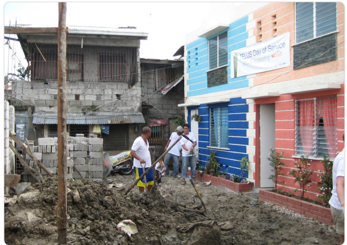
Anciennes maisons et maisons rénovées
