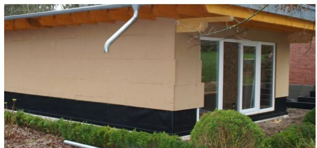
Abdichtung für Bodenplatte und Sockelbereich
