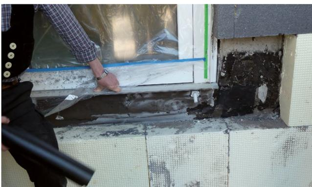
Nicht funktional: Abdichtungsversuch am Türanschluss mit einer Bitumendickbeschichtung. So bitte nicht.
