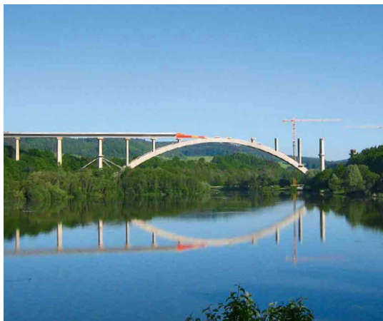
Talbrücke Froschgrundsee bei Weißenbrunn vorm Wald
