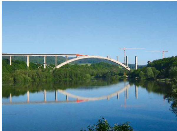
Talbrücke Froschgrundsee bei Weißenbrunn vorm Wald
