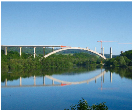
Talbrücke Froschgrundsee bei Weißenbrunn vorm Wald
