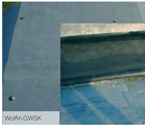
Wolfin GWSK auf einer kaschierten Zusatzdämmung.
