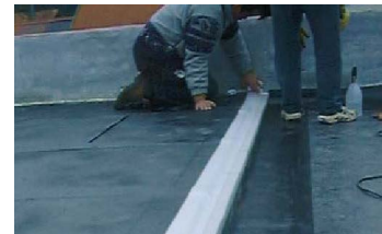
Wolfin GWSK auf einer kaschierten Zusatzdämmung.
