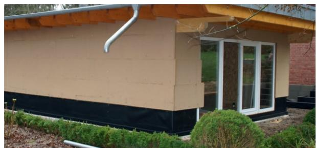
Abdichtung für Bodenplatte und Sockelbereich
