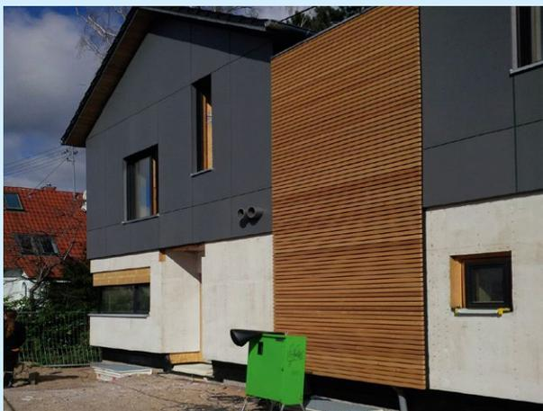
Das Doppelhaus der Firma Holzbau Koppert in Walldorf wurde komplett im Holzrahmenbau errichtet. Für einen sicheren Sockel sorgen 70 m umlaufender Abdichtung aus Wolfin IB in 1,5 mm Dicke. Die Anschlüsse an die Türen wurden mit Wolfin Verbundblech ausgeführt.
