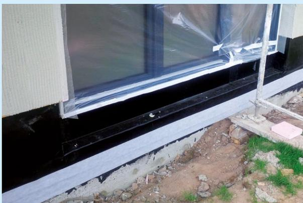
Auch das durch die Firma Meditbau ausgeführte Wohngebäude im Holzrahmenbau verfügt über einen umfassenden Schutz mit Wolfin IB. Die Abdichtung der Bodenplatte wurde durch eine Schicht Witec KV pro vor Verschmutzungen im weiteren Arbeitsverlauf geschützt.
