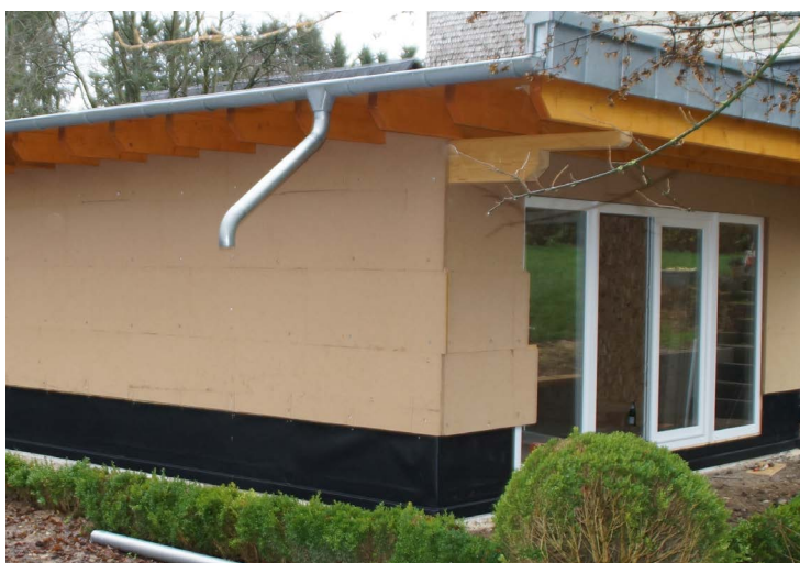
Sockelabdichtung mit Wolfin IB.
