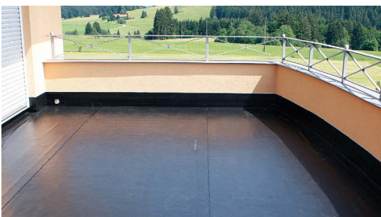
Terrassen- und Balkonabdichtung
