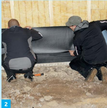
2 Die Wolfin Bahn und die Wand werden mit Teroson AD Adhesive Spray eingesprüht; nach der Abluftzeit wird die Bahn aufgeklebt. Eine Alternative hierzu sind die selbstklebenden GWSK Zuschnitte. Als Montagesicherung werden die Bahnen mit geeigneten Befestigungsmitteln an der Oberkante gesichert.
