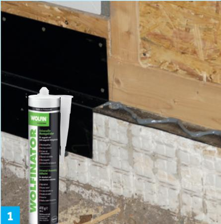
1 Die gekanteten Verbundbleche werden mit Wolfinator auf dem Untergrund verklebt und bei Bedarf (z. B. bei Unebenheiten) zusätzlich mechanisch befestigt.
