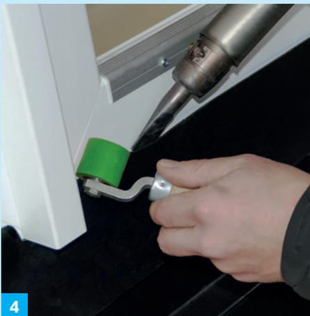
4 Die Wolfin Dichtungsbahnen sind so flexibel, dass auch der Anschluss an PVC-Türen und -Fenster kein Problem darstellt. Da Wolfin ohne offene Flamme verschweißt wird, besteht hier auch keine Gefahr von Verbrennern an den Rahmen.
