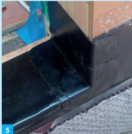
5 An Detailpunkten wie Innen- und Außenecken empfiehlt es sich, vorgefertigte Wolfin Systemprodukte wie z. B. Innen- und Außenecken aus homogenem Material zu verwenden und mit Heißluft aufzuschweißen.
