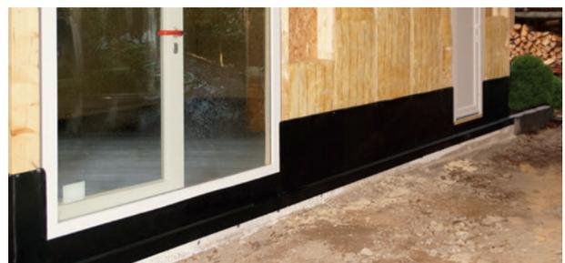
Rissüberbrückende Abdichtung für Bodenplatte und Sockelbereich **5**
