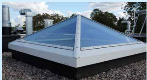
Lässt Sonnenlicht herein, aber kein Wasser: Pyramiden-Lichtkuppel.
