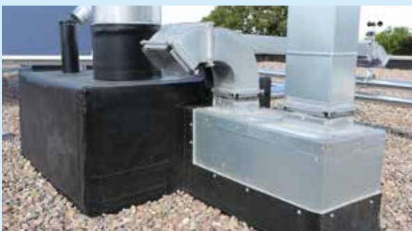
Haustechnik auf dem Dach: Abdichtungsarbeit für Profis und Profi-Material.
