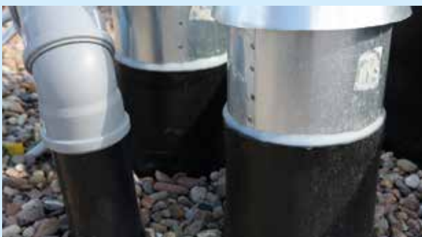
Diffizile Detailarbeit: handgefertigte Manschetten für die Rohre.
