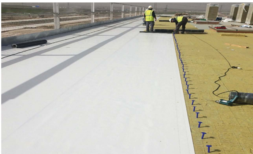
EverGuard TPO eignet sich optimal für Industriedächer und Großflächen
