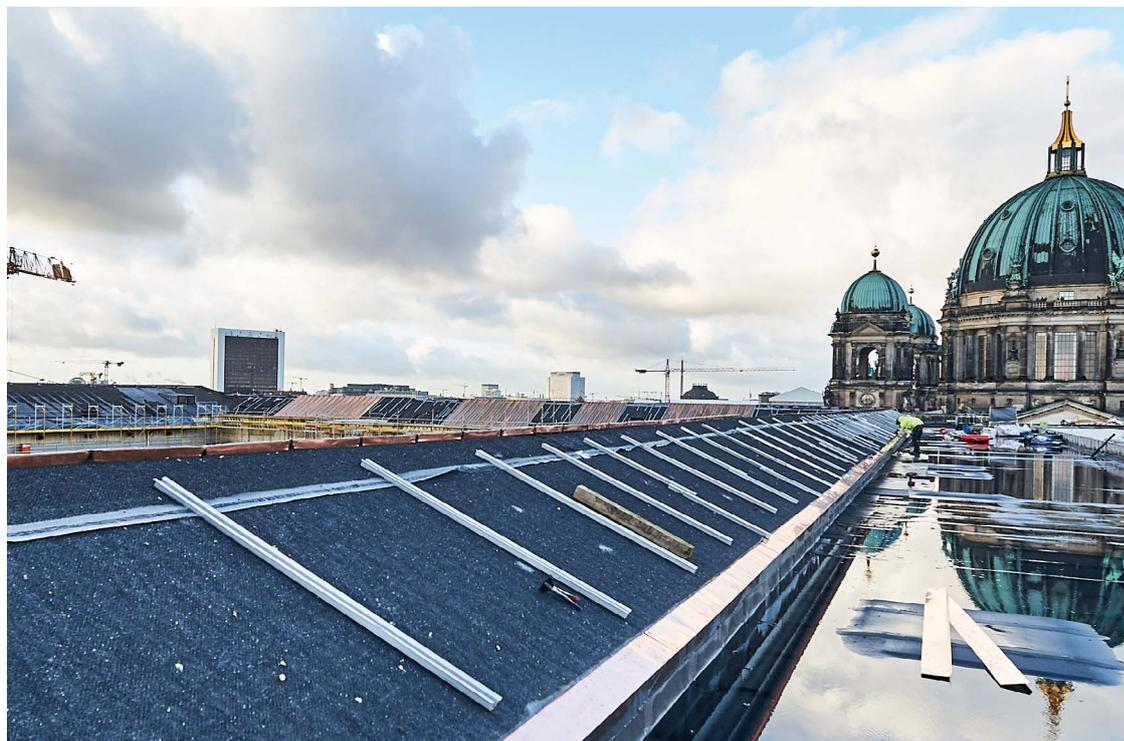
Während finale Abdichtungen durch das Aufbringen einer Gefälledämmung in aller Regel mit einem Mindestgefälle von 2 % konstruiert werden können, haben Behelfsabdichtungen mit Wasserstau zu kämpfen, denn die Unterkonstruktion ist meist ganz oder teilweise gefällelos ausgebildet oder weist sogar Gegengefälle auf. Geneigte Unterkonstruktionen sind aufgrund der geregelten Wasserführung weniger kritisch. Wasseranstau kann jedoch beispielsweise in Kehllinien auftreten.
