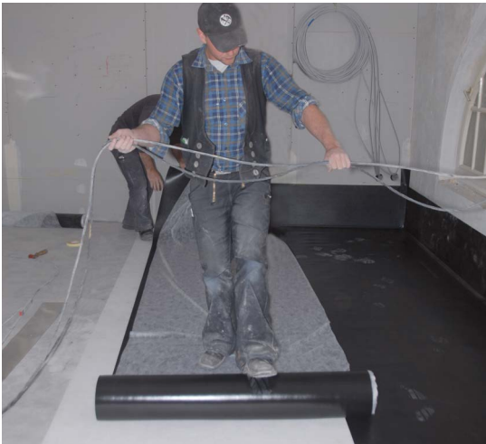
Entscheidend: die Abdichtungslage Wolfin IB, im Nahtbereich quellverschweißt.
