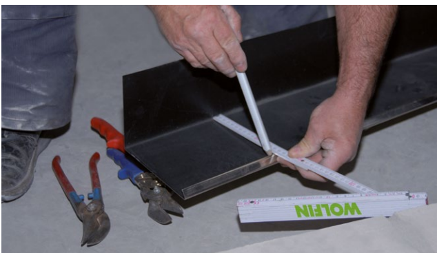
Sorgfalt beginnt bei der Vorbereitung: Zuschnitt und Montage der Wolfin Edelstahl-Verbundblechelemente.
