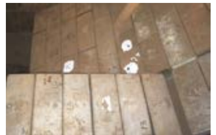
Revêtement Duablock 80/20 avec Smartliner installé
