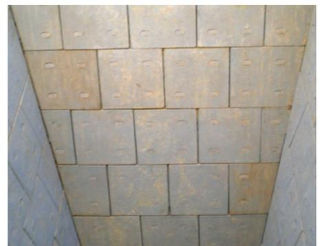
Conducto revestido con Duracast DC17
