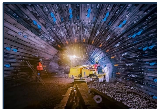
Chemises composites installées et en cours d'utilisation
