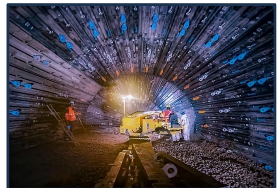
Revestimentos compostos instalados na
