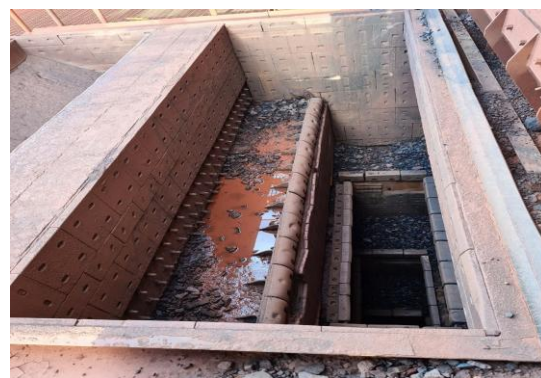
Тесное пространство с несколькими глубокими уровнями, что затрудняет подъем тяжелых элементов обшивки по одному
