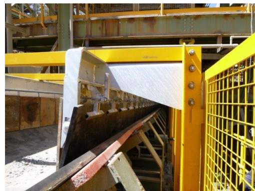
Vista definitiva da instalação do revolver
