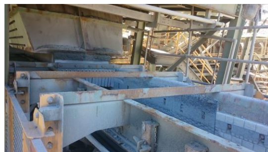
Calha de descarga com revestimentos laterais
