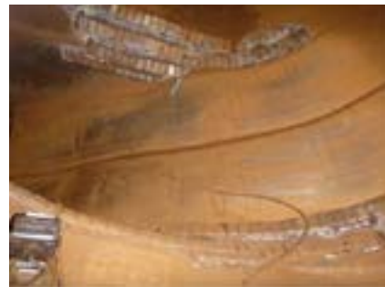
Изношенные стальные вкладыши AR во время ремонта
