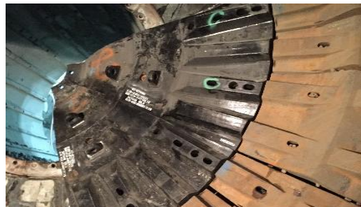
Процесс установки 1го сегмента из 9 частей 9-сегментной-системы
