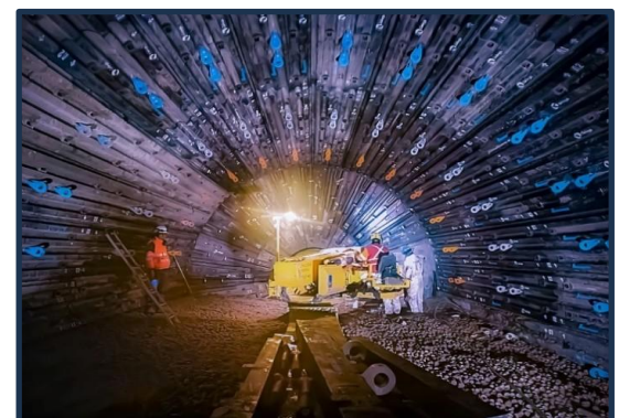
Revestimientos compuestos instalados en funcionamiento
